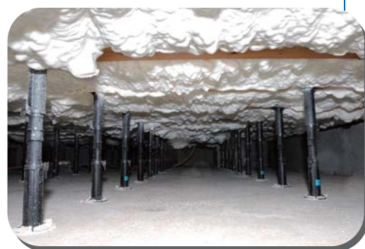
床断熱リフォーム
