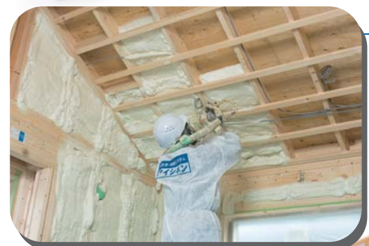
屋根断熱リフォーム
