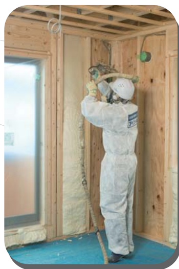
壁断熱リフォーム
