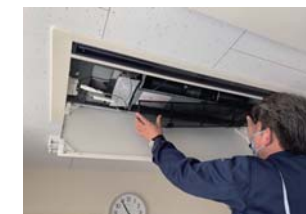
建物改修工事後アフター業務
