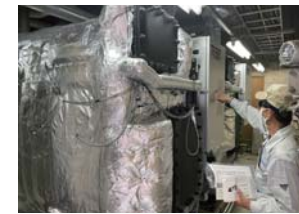
建物設備点検業務
